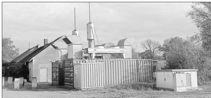
Zwei BHKW am Standort Schlöben in Containerlösung Foto: Aufn. K.Schmidt
