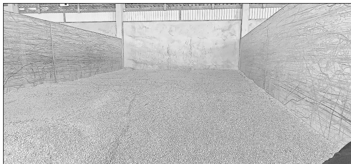
Trockenbox mit Körnermais, die Belüftung erfolgt von unten Foto: Aufn. K.Schmidt
