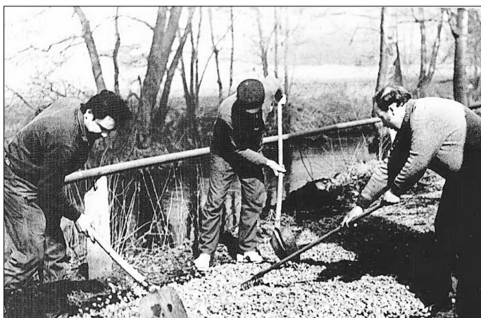
1980 / Straßenbau durch die Sportfreunde. Der Badweg wurde mit einer Bitumendecke versehen.
