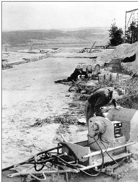
Teildemontiertes Anlassgerät, Start- bahn/Walpersberg, 1945
