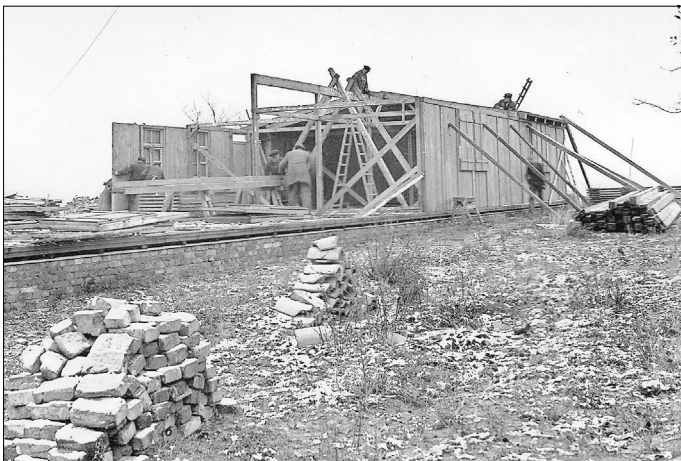
Abriss der Baracken
