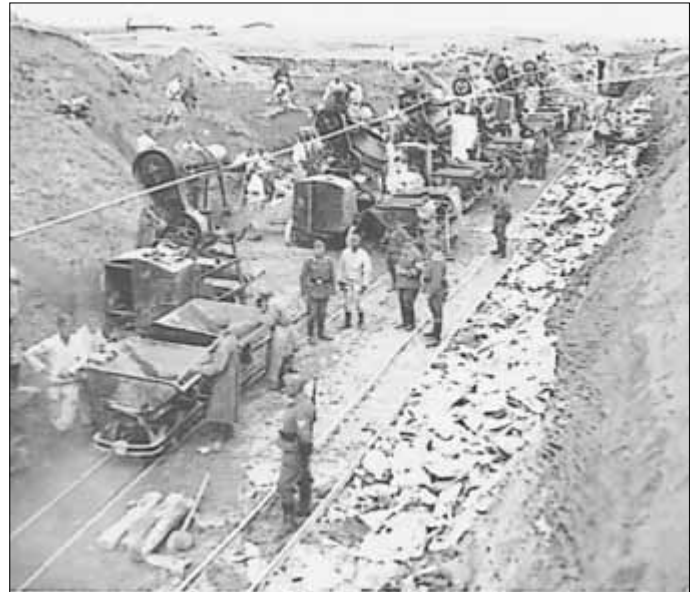
Gleisverlegung im Hirschgraben
