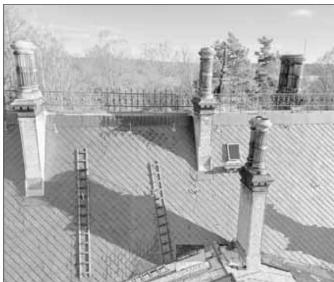
Zu Restaurieren waren auch die zahlreiche „englischen“ Schornsteine der Dachlandschaft (Foto Hohberg)
