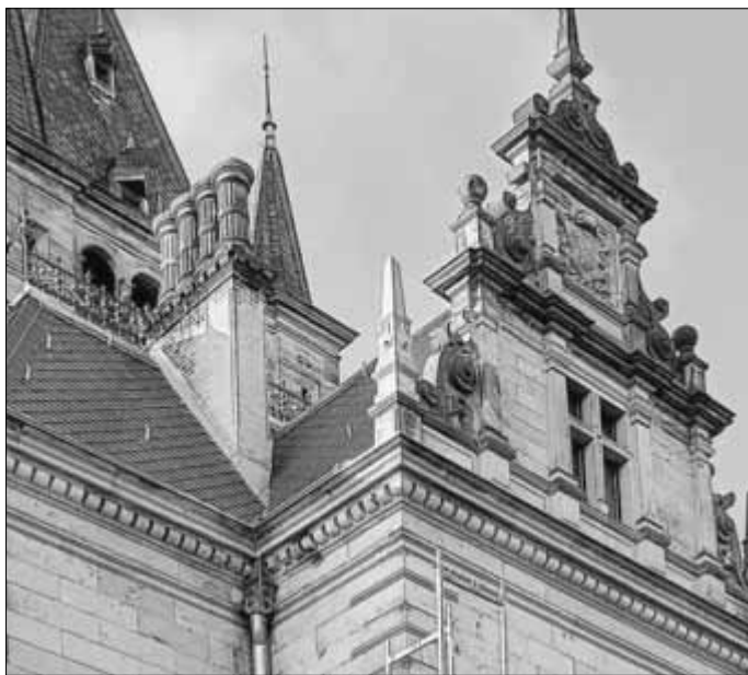
Nun ist das Gerüst gefallen und die Dachlandschaft des Herzogin-Agnes-Flügels erstrahlt in neuem Glanz (Foto Hohberg)
