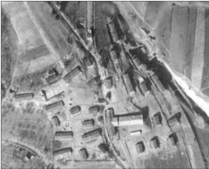
Baulager 1, am Walpersberg
