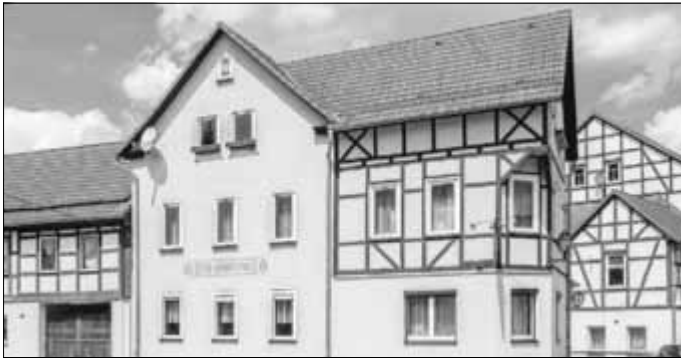
Ehemaliges Lager in Niederkrossen
