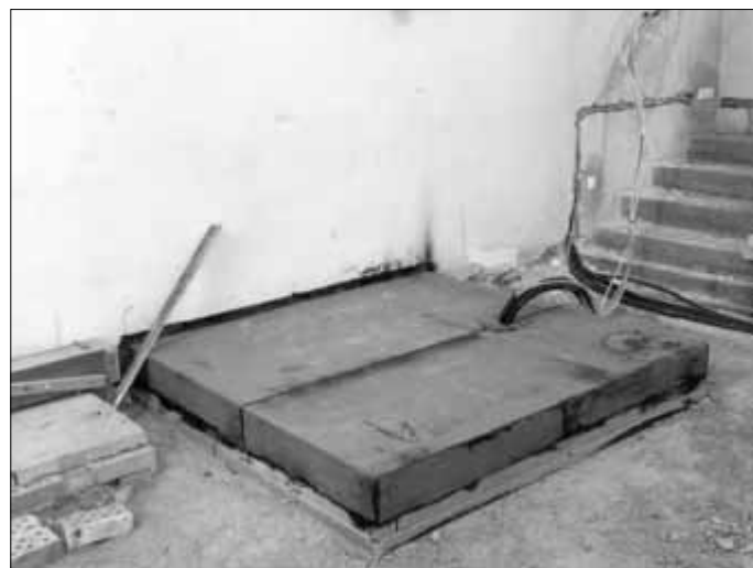
Fundament für den ersten Teil der neuen Johann-Walter-Orgel (Foto: M. Hellwig)
