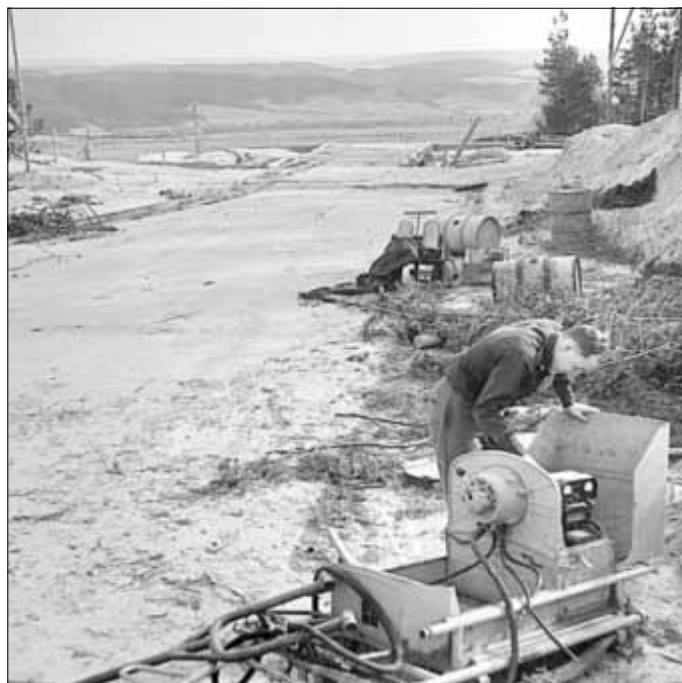
Holzabdeckung über der Windenkammer an der Anfahrrampe und Startvorbereitungsplatz
