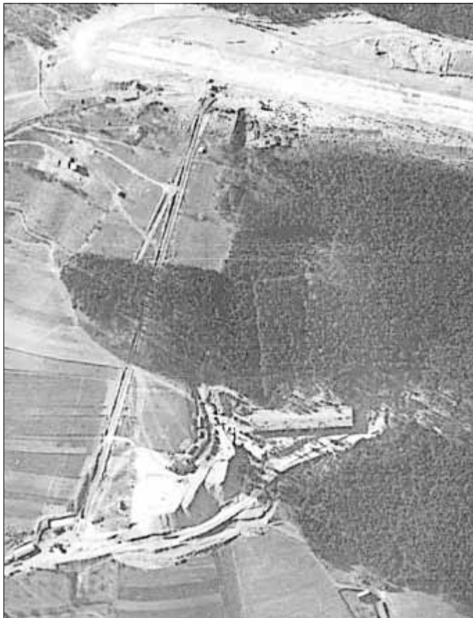
Halle 6, Nordseite Walpersberg, links Materialaufzug
