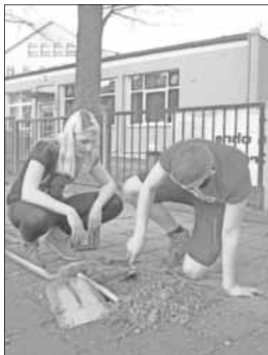
Gehwegplatte wackelt - kein Problem, ist eine Kleinigkeit für den auszubildenden Hoch-Tiefbauer im 2. Abj.
