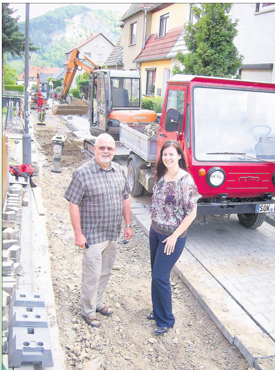
Bauamtsleiter Herr Sporleder und Bürgermeisterin Frau Nissen vor Ort Am Kreuz
