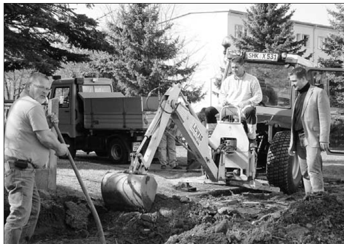
von links: Vorarbeiter Jürgen Knabe, Baggerführer Stefan Arper, Hauptamtsleiter Albert Helmut Weiler
