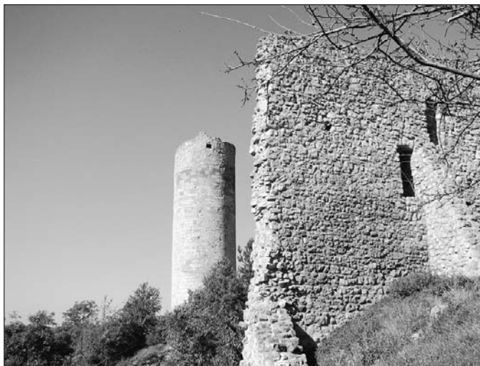
Brandenburg Blick zur Westburg
