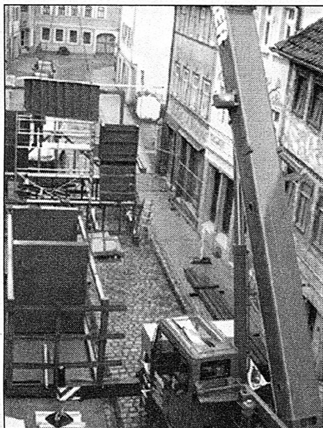
Am 24. September 2004 hob ein Schwerlastkran das vor dem Museum in der Margarethenstraße vormontierte Stahltreppenhaus über das Dach in den Hof auf das vorbereitete Fundament.
