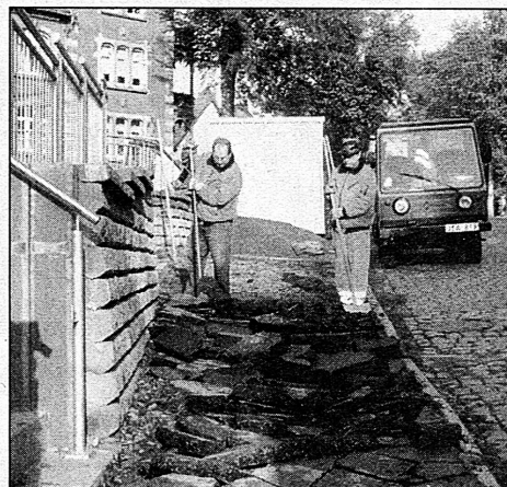
Joachim Schlender (l.) und Frank Günther beim Herausbrechen des alten Bitumenbelages
