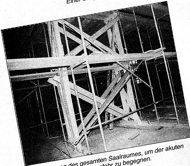
Einer der gebrochenen Dachbalken
