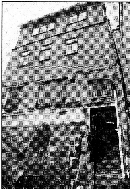
Das Hinterhaus auf der Stadtmauer wird durch einen Neubau ersetzt.
