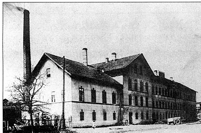
Die alte Lehmannsche Porzellanfabrik von 1864 - 1922
