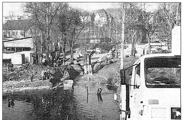
Kanalleitungsbau durch die Saale, vorwiegend für das Abwasser aus dem Verbandsgebiet Uhlstädt und Orlamünde geplant.
