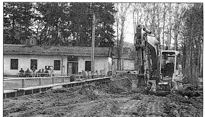
Tiefbauarbeiten durch den Kahlaer Sportplatz für den Hauptsammler, an den Orlamünde und Uhlstädt mit Hexengrund angeschlossen werden sollten.
