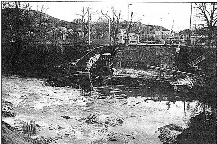
Wo einst die Brücke die Mühlache überspannte, wühlt zur Zeit der Bagger im Flußbett, um auch hier die Fundamentarbeiten vorzubereiten.
