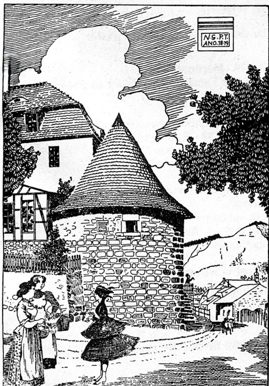
Der Malzturm, 1819 erniedrigt.
