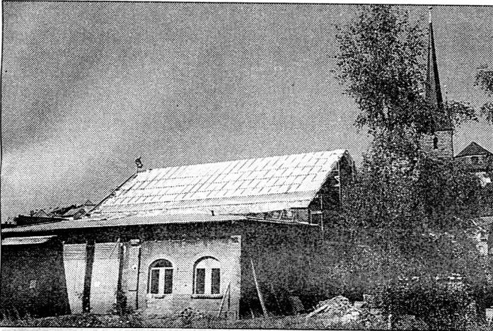
Das Dach der alten Gasanstalt wird derzeit neu gedeckt, nachdem die gesamte Dachstuhlkonstruktion erneuert worden ist. Die Arbeiten an der Fassade dienen der Wiederherstellung der historischen Außenansicht des Gebäudes. Der Einzug des Bauhofes in diesen Komplex ist noch in diesem Jahr vorgesehen.
