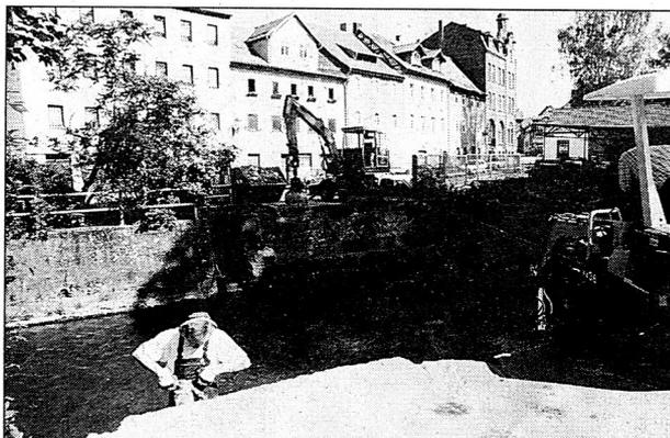
Wie auf dem Bild zu sehen ist, wurde mit dem Abriß der Mühlflachbrücke in der Gerberstraße bereits begonnen. Gegenwärtig werden Arbeiten an den Brückenfundamenten durchgeführt, die die neue kleine Brücke aufnehmen werden. Die Fertigstellung dieser Brücke ist bis Ende der 28. Woche, das heißt also Mitte Juli 1999 geplant.
