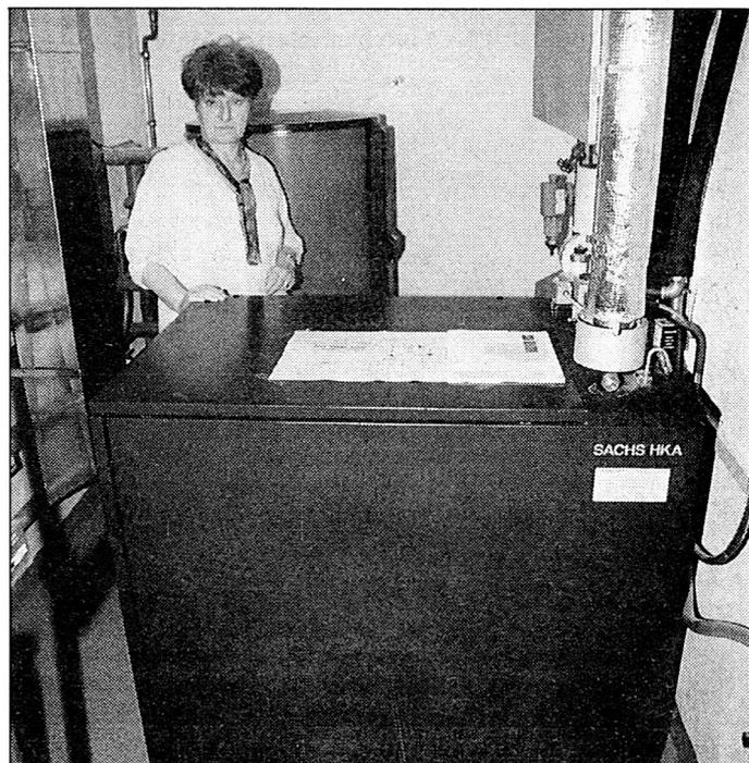
Gertraud Thieme ist auch bereit, allen Interessenten den kleinen Einzylindermotor im Betrieb zu zeigen, der handlich 12 kW Wärme bereit stellt, während er 5 kW in das Stromnetz speist. Terminvereinbarung nimmt das Saalehotel unter der Rufnummer 036424 - 22479 gern entgegen.
