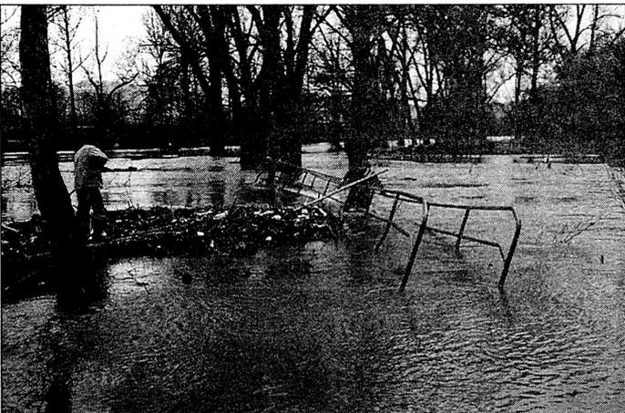
Der durch das angeschwemmte Holz hervorgerufene Druck hat den Steg mit samt den Eisenbahnschienen regelrecht verbogen.
