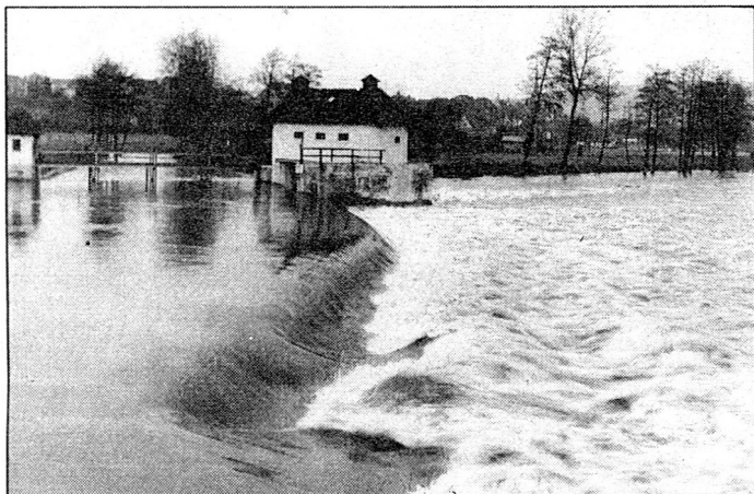
Bei hohem Wasserstand wird die Saale zu einem reißenden Fluß der rechts u. links die Ufer überschwemmt.
