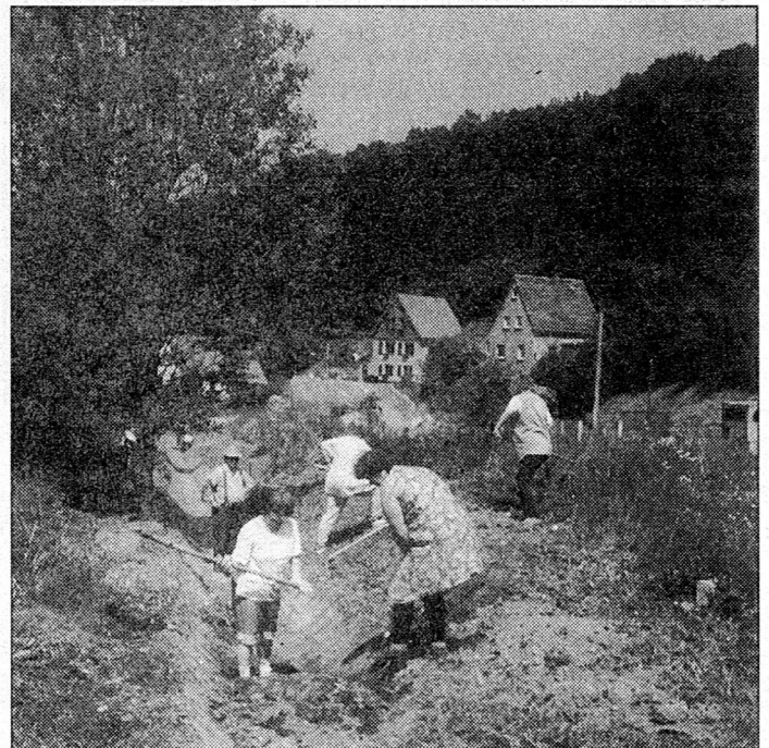
Die Frauen-ABM bei der Anlage eines Flutgrabens in der Lindiger Straße.
