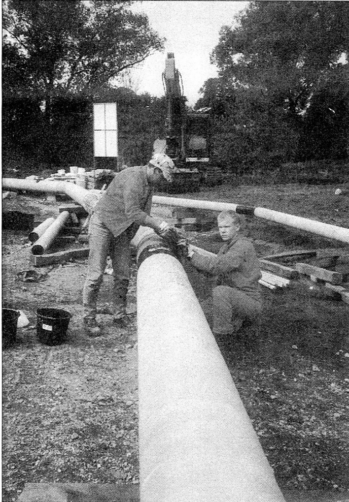
Mitarbeiter der Baufirma Streicher montieren die Erdgasleitungsstrasse, die künftig als Saalebrücke die Verbindung des Ortsnetzes zwischen Löbschütz und Kahla herstellt.
