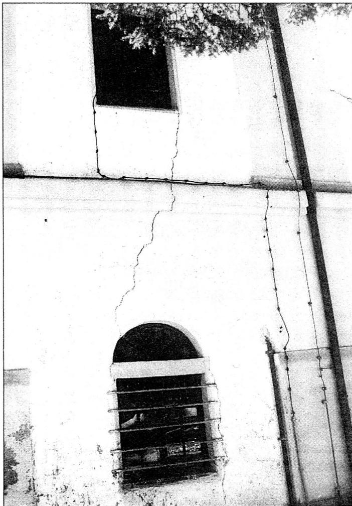
Am Torgebäude sind an allen Seiten Risse in der Fassade zu sehen, die durch Setzungserscheinungen im Fundamentbereich entstanden sind. Ursache hierfür kann die defekte Dachentwässerung sein, wodurch das in den Fundamentbereich eindringende Wasser den Kalkstein ausspült und dadurch Hohlräume entstanden sein können. Auch an anderen Gebäuden ist die Dachrinne bzw. die gesamte Dachentwässerung total zerstört.
