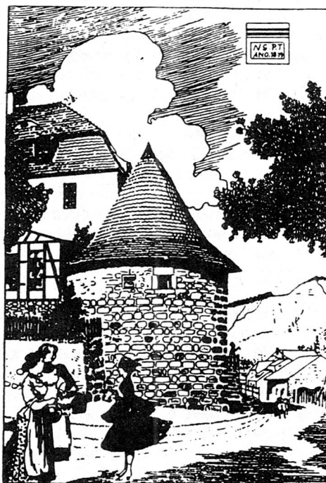
Malzturm auch Roter Turm genannt am oberen Walkteich.
