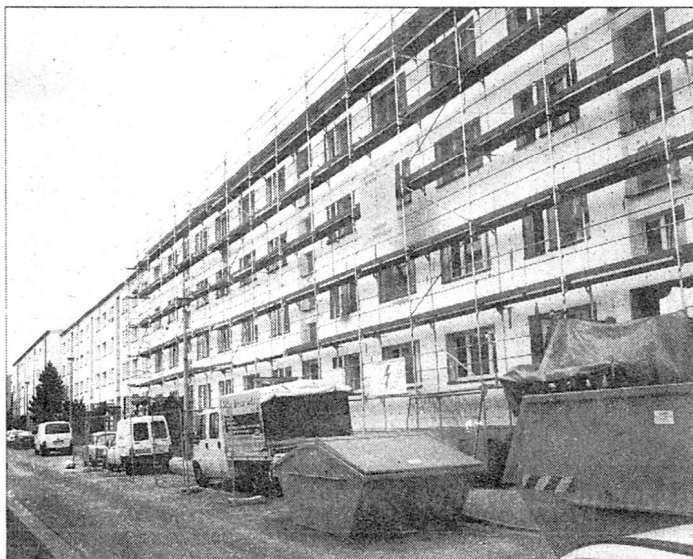
Wärmedämmung an einer Außenwand in der Schorndorfer Str.
