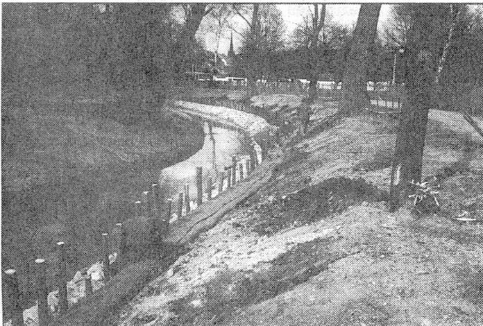
Im oberen Mühlachebereich, am Freibad, sind Arbeiten zur Ufergestaltung im Gange. In Gewebebahnen wird Erde „eingenaht“, in die die Stecklinge zum Lebendverbau eingebracht werden. Holzpalisaden und Steinanschüttungen sollen dafür sorgen, daß die neue Uferbepflanzung nicht weggespült wird.
