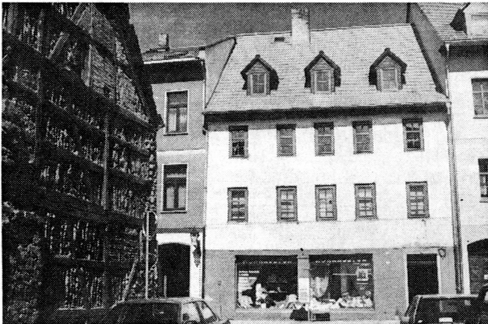
Dieses Haus wurde mit Fördermitteln saniert.
