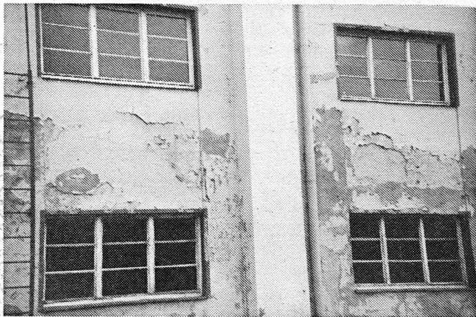
Maroder Außenputz war ein Angriffspunkt für die zerstörerische Nässeeinwirkung.
