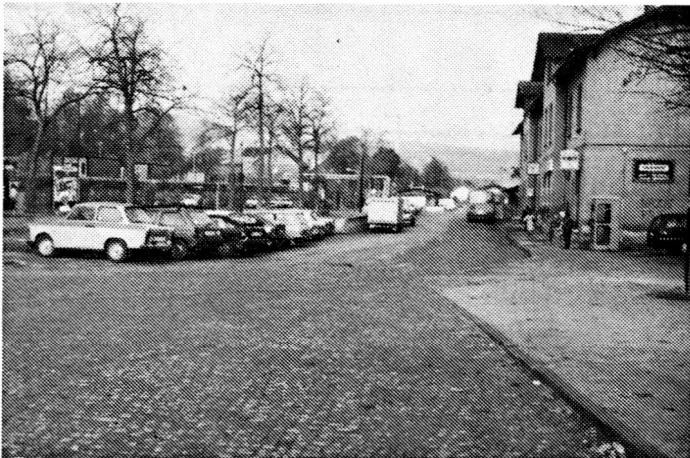
Der Platz vor der Sanierung
