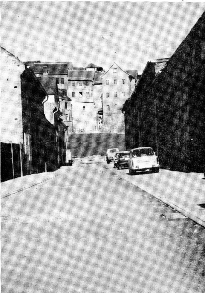
In der Scheunengasse ist die Bitu-Tragschicht eingebaut worden.
