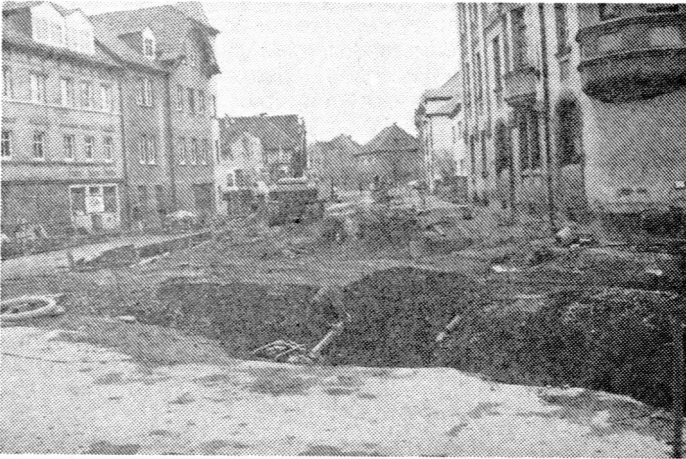
Arbeiten an der Gasversorgung
