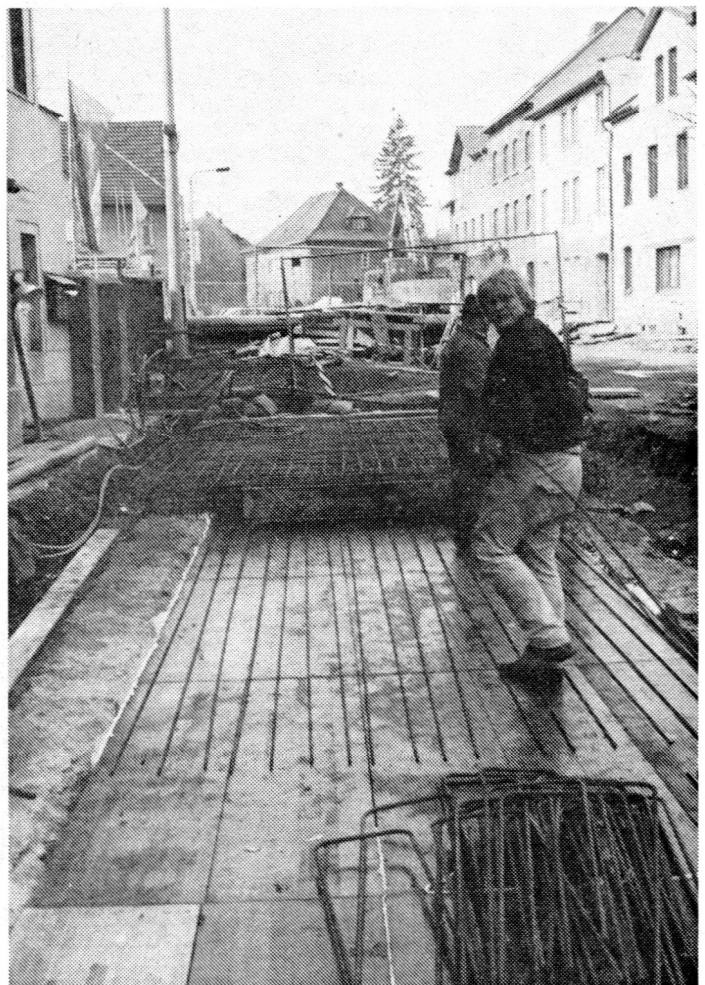
Bewehrungseinbau von Hand
