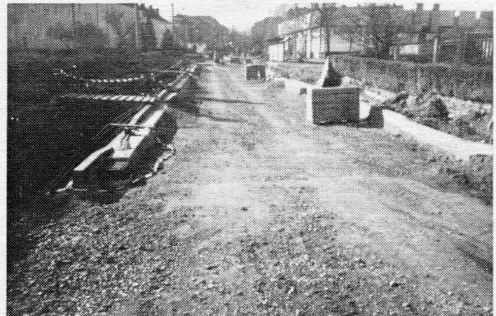
Der Straßenbau ist soweit fortgeschritten, daß das Erdplanum hergestellt ist und ein großer Teil der Frostschuttschicht bereits eingebaut ist. Auf beiden Seiten sind die Bordsteine gesetzt und auf einer Seite bereits die Rinnenplatten.
