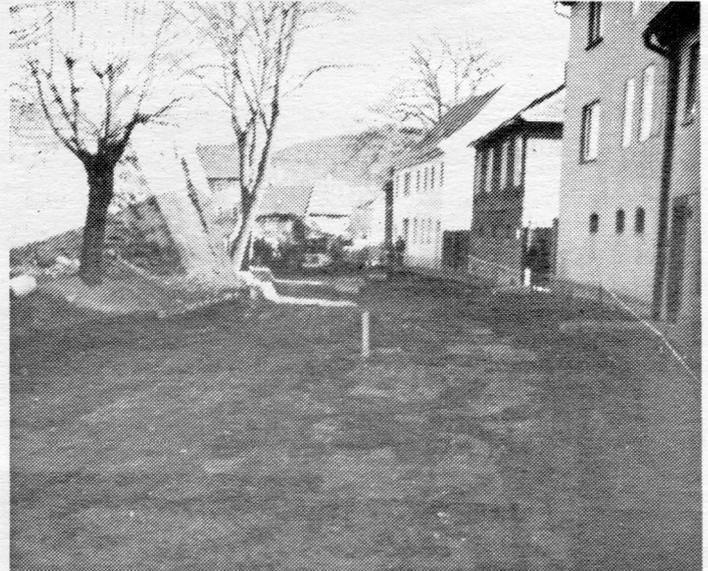
Das Foto zeigt den hinteren Teil der Heimbürgestraße nach der Auskoffierung für den Straßenbau. Der Boden unter dem Erdplanum ist teilweise so stark durchnäßt, daß er gegen gutes verdichtungsfähiges Material ausgetauscht werden muß.
