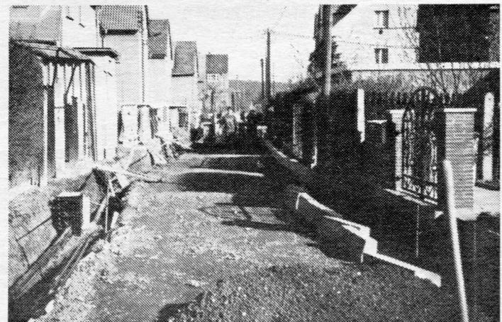
Das Erdplanum ist hergestellt und der Frostschutz zum größten Teil eingebaut. Rechts ist bereits mit dem Versetzen der Bordsteine begonnen worden. Auf der linken Seite sind die Kabel für die Straßenbeleuchtung verlegt und die Kabelschächte gesetzt.
