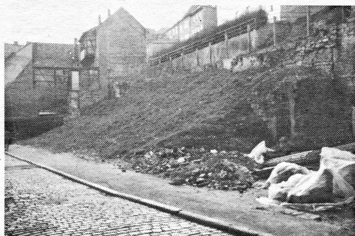
Innerstädtische Baulücke in der Saalstraße.
