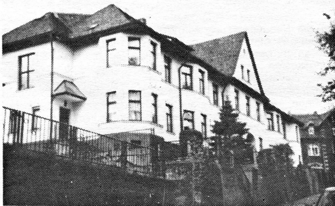
Die Kinderkrippe vor der Dachsanierung
