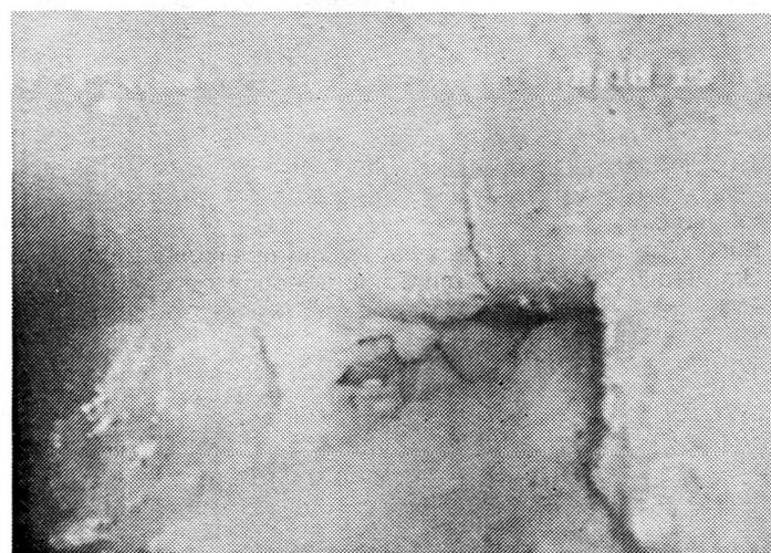
Die Videobilder zeigen den Zerstörungsgrad der Abwasserleitung im Neubaugebiet.
