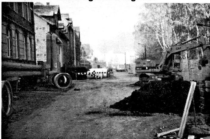
Im Bauabschnitt II haben die Tiefbausanierungsarbeiten im Bereich Thälmann-Straße bereits im vergangenen Jahr begonnen. Durch die Firma Kunz werden hier die Rohre für Regenwasser und die Rohre für Abwasser durch das Gelände des Porzellanwerkes bis auf die Westseite der B 88 verlegt. Auf dieser Seite arbeitet bereits die Firma Faber am weiteren Anschluß der Leitungssysteme in Richtung Gewerbegebiet.
